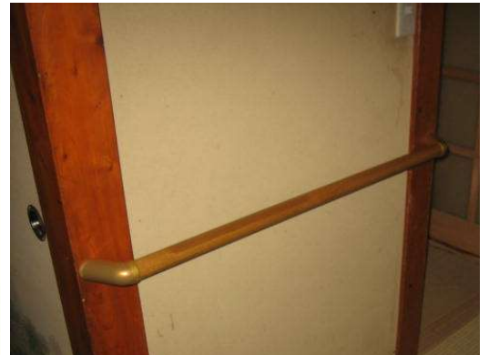
手すりを取り付ける事により廊下での移動も安全に行え
