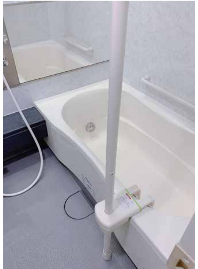
浴槽縁の幅の幅違い（大）
