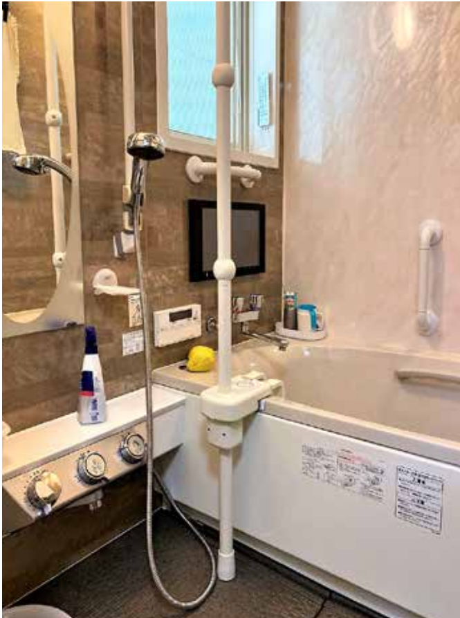
エプロンに強度がない浴槽
