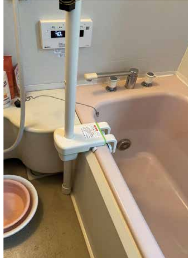
エプロン外段差（プラス段差）
